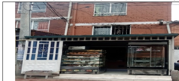
Fotografía N°. 1 Fachada del Predio.
