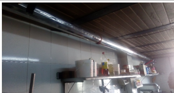
Fotografía N°. 3 Ducto Interior del Establecimiento
